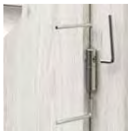
regulacja zawiasów czopowych regulowanych 3D
