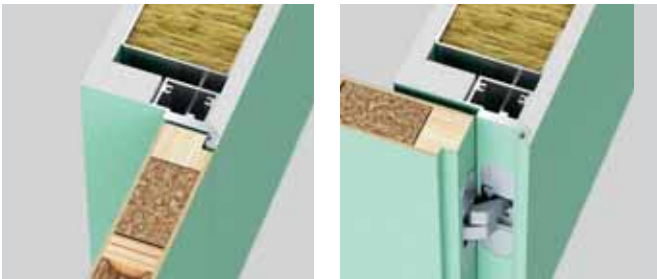
Odwrotna przylga (otwierane do wewnątrz) - drzwi lewe
